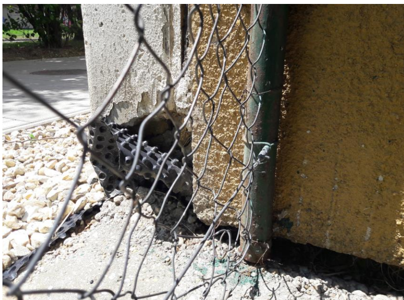
19 blok A poškodený rohový panel
